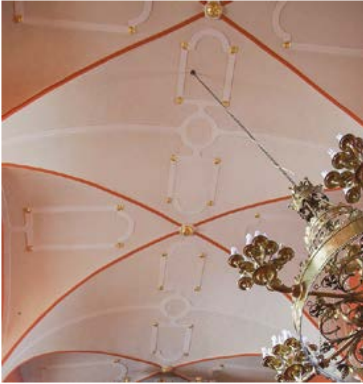
Ryc. 9. Sklepienie nawy głównej, pierwotne wykonanie w 1688 r. Stan z 2025 r. Fot. M. Cielińska-Idziak
