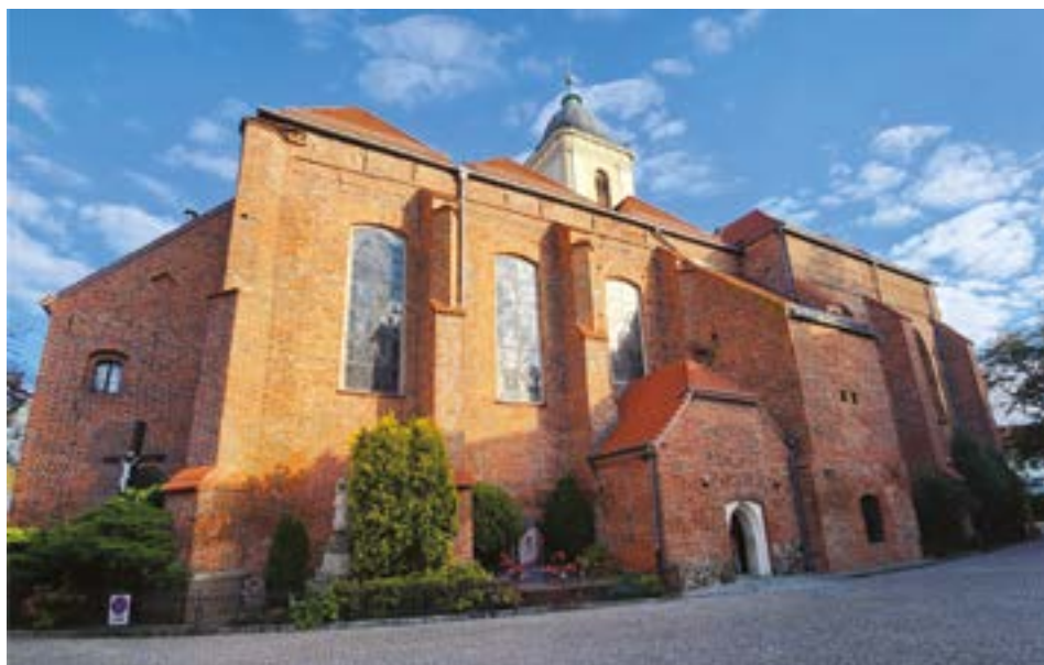
Ryc. 42. Konkatedra. Widok od strony południowo-zachodniej. Stan z 2025 r. Fot. M. Celińska-Idziak
