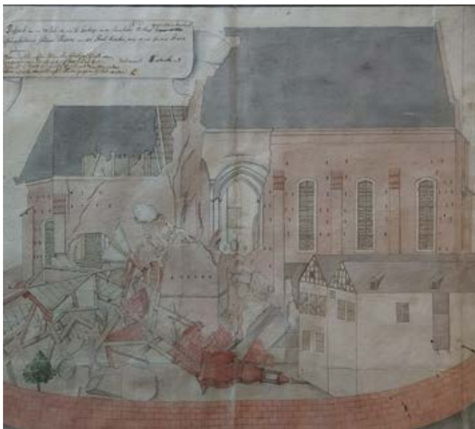
Ryc. 15. Zburzona wieża kościoła parafialnego w dniu 14 lipca 1776 r. Źródło: Archiwum Diecezjalne w Zielonej Górze, Acten betreffend die durch dem Einsturz des Turms Beschädigte hiesigen katholischen Kirchen und derselben Wiederherstellen vom 15 Juli 1776 bis den...
