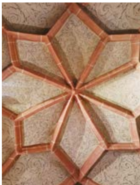
Ryc. 7. Sklepienie gwiaździste w Kaplicy Chrzcicielnej z początków XVI w. Stan na rok 2025. Fot. M. Celińska-Idziak
