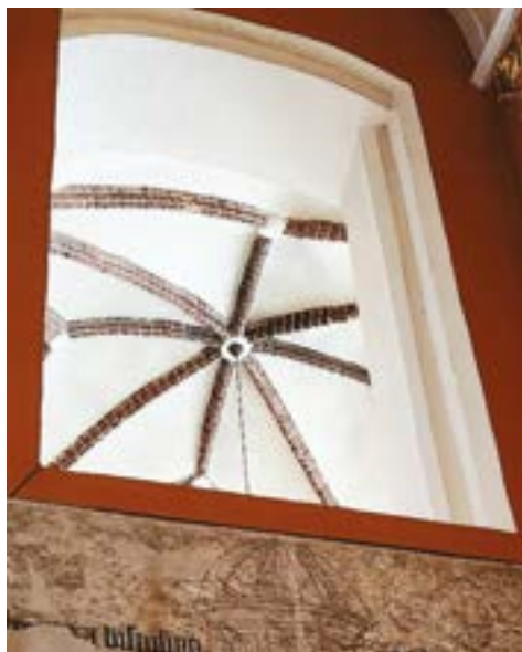
Ryc. 6. Sklepienie na II kondygnacji w Kaplicy Ogrójcowej (Książęcej). Stan na rok 2025. Fot. M. Celińska-Idziak
